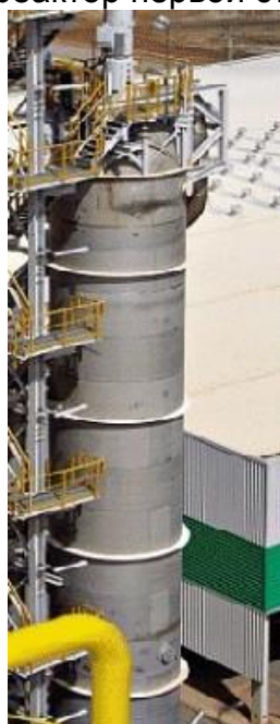
Рисунок 2.9. Кислородный реактор первой ступени 2.13 и кислородный реактор второй ступени 2.16.
