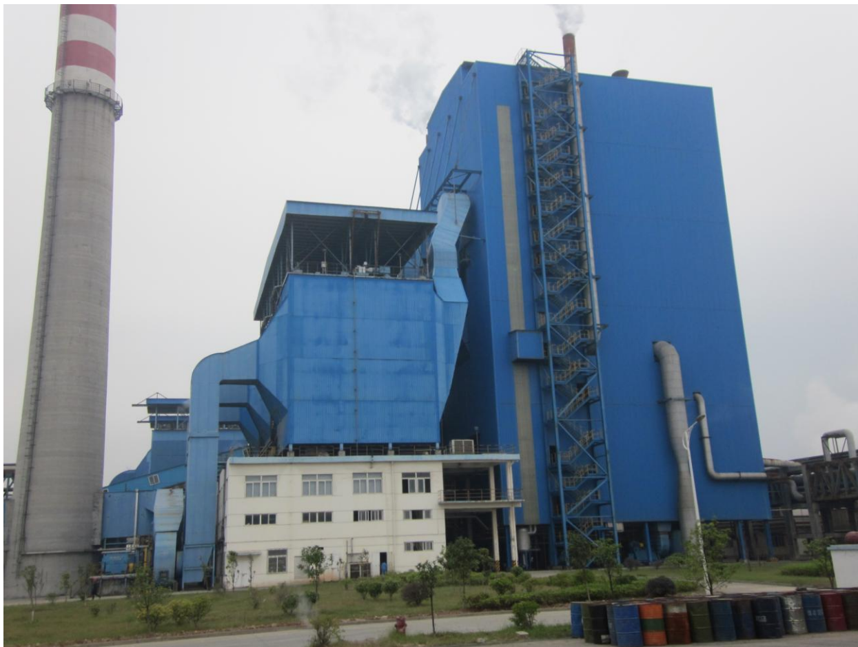
Рисунок 19.1 Котел-утилизатор СРК 19.2
