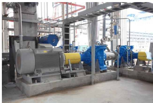
Рисунок 2.3. дозирующий шнек 2.3 и щеповый насос 2.4.
