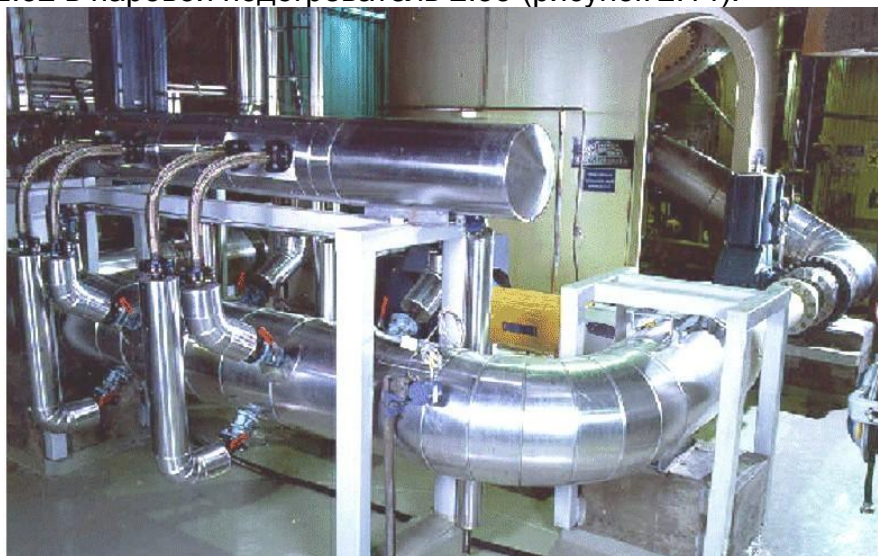
Рисунок 2.14. Паровой подогреватель 2.33
